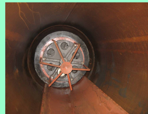
Комплексные испытания УВГ
